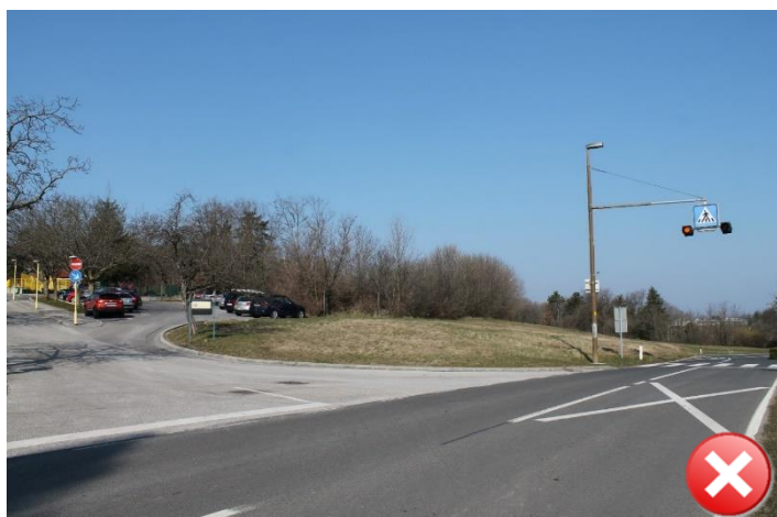
Slika 7: Nevaren odsek brez pločnika iz smeri Skopo.
